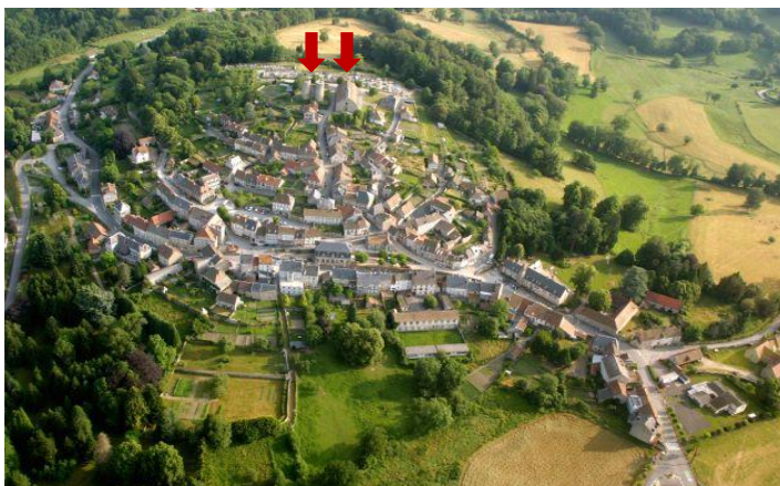
Figure 10 : vue aérienne de la cité médiévale de Crocq
