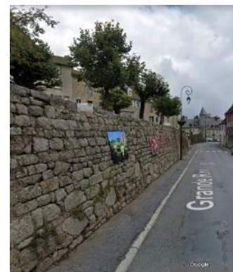
Figure 4 : des trottoirs étroits
